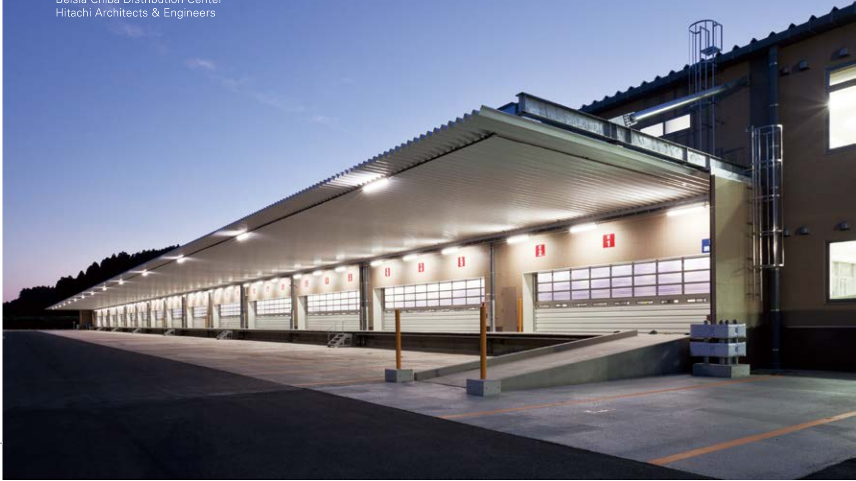
トラックヤード夜景
