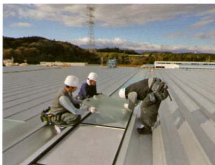
ガスケット・ガラス挿入
