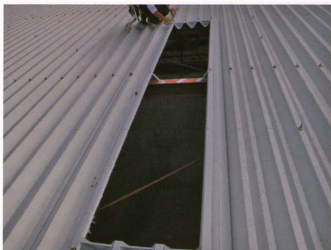
屋根面の開口部
