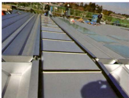
拡散板のシール
