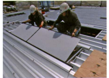
拡散板の取付
