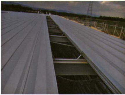
開口部確認 断熱見切り、吊子、はぜ締め
