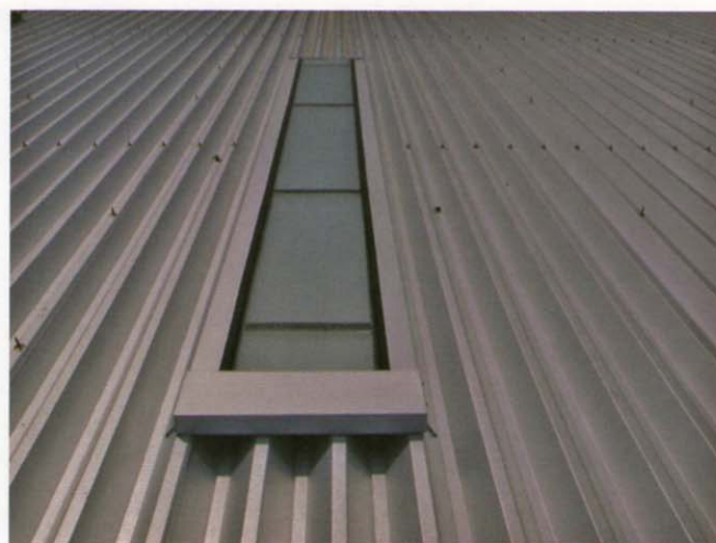
仕上がった天窓
